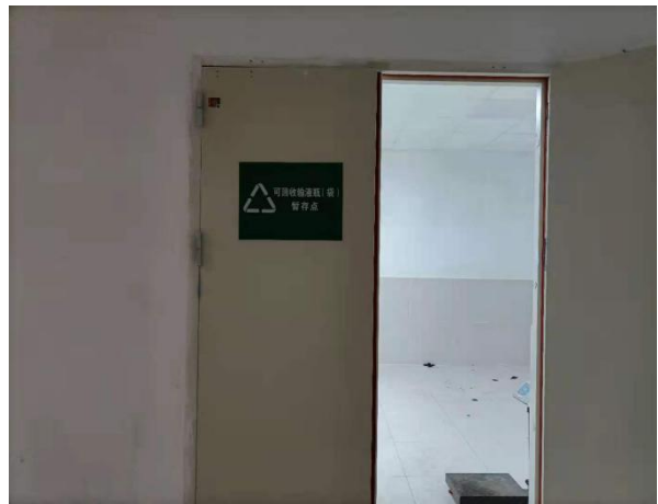
一般固废堆放处
