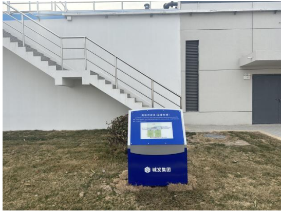
高效沉淀池（深度处理）
