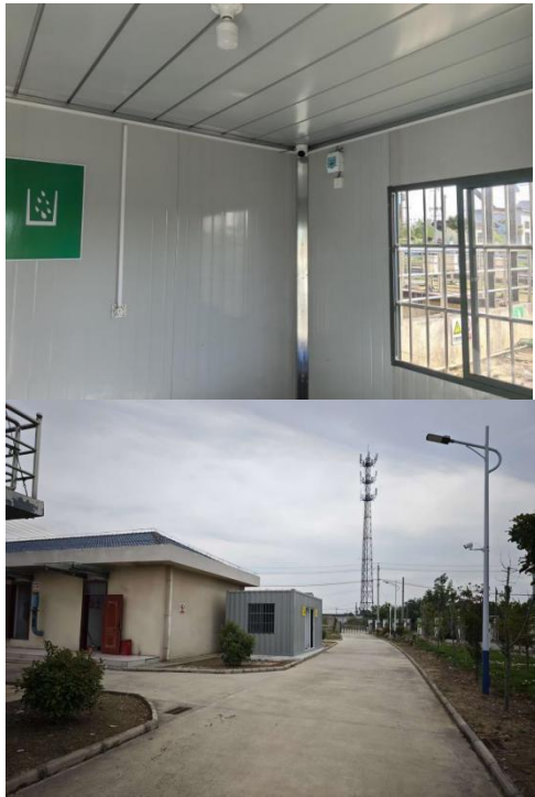
危废仓库内外摄像
